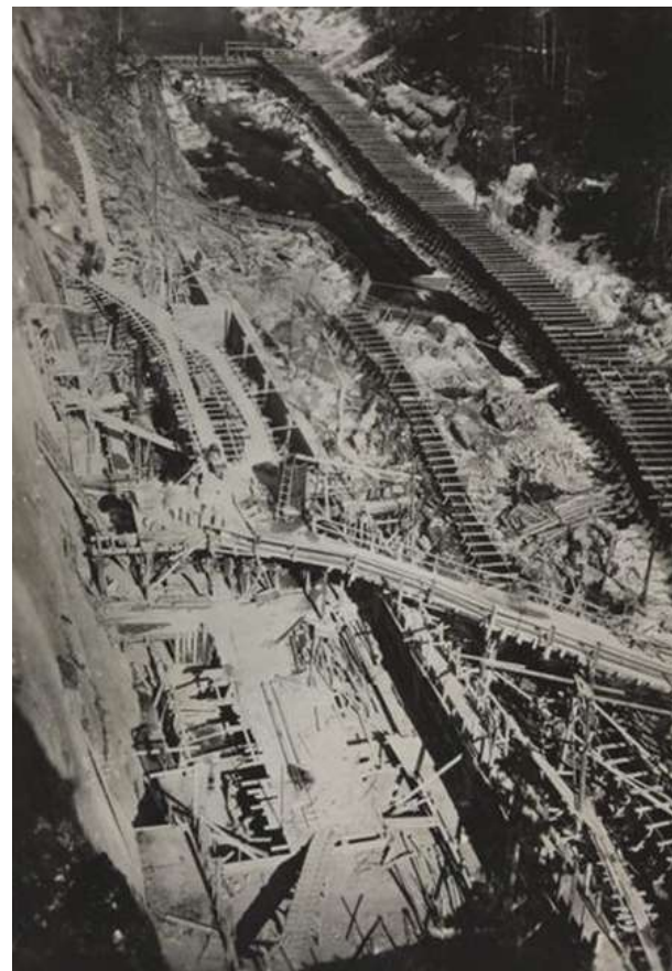
Svelgfoss kraftverk under bygging
